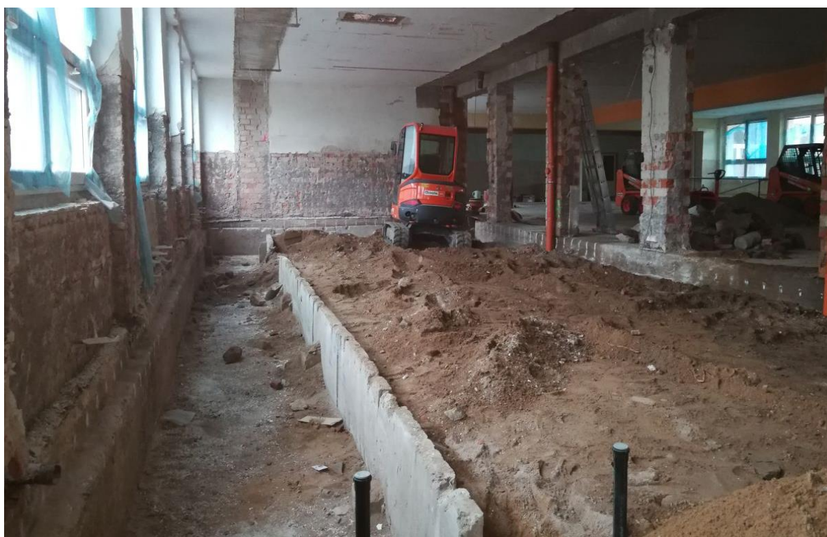
Rekonstrukce školní jídelny (2019)
